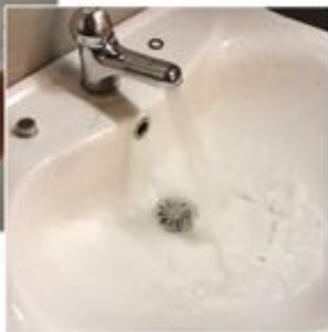
« prima del nostro intervento »
